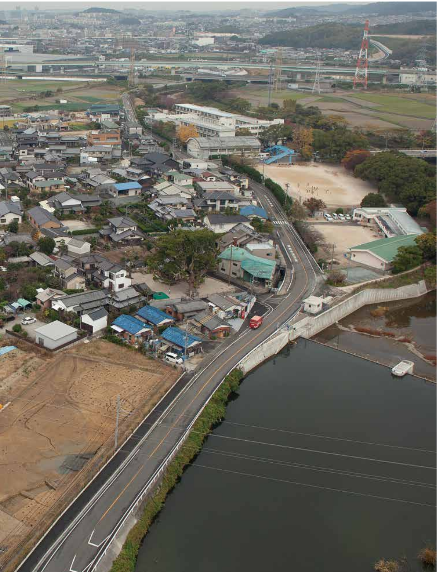
調査地全景と多々良川(南東から)
