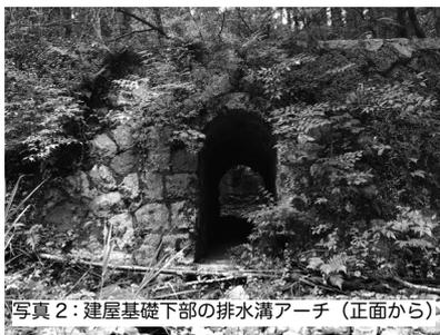
写真2: 建屋基礎下部の排水溝アーチ (正面から)
