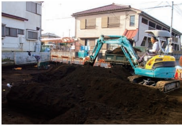
3. 表土剥ぎ作業風景
