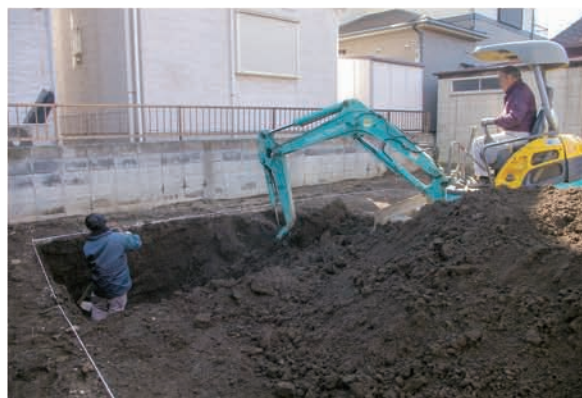
2. 表土剥ぎ作業風景
