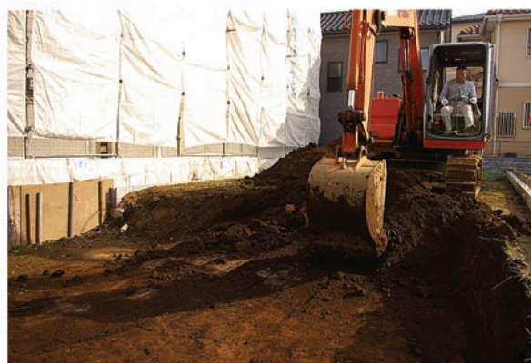
8. 第62⑦地点表土剥ぎ風景
