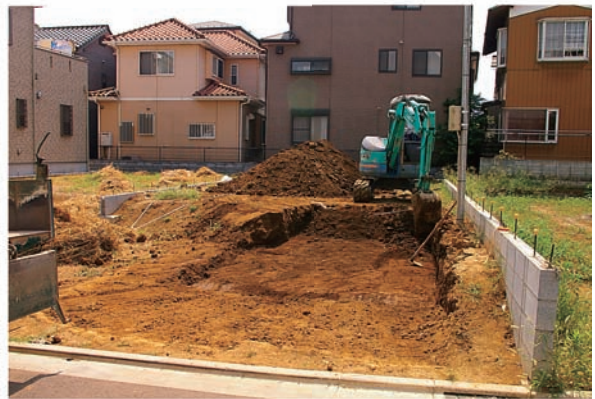
4. 第62⑨地点表土剥ぎ風景
