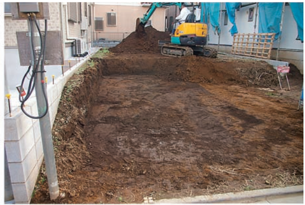
2. 第62⑧地点表土剥ぎ風景
