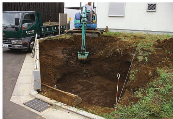
2. 第62①地点表土剥ぎ風景
