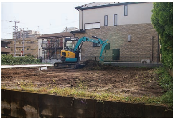
1. 表土剥ぎ風景
