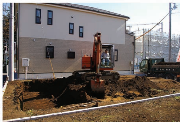
4. 第62③地点表土剥ぎ風景
