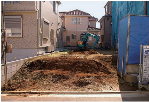
1. 第62⑧地点調査区近景
