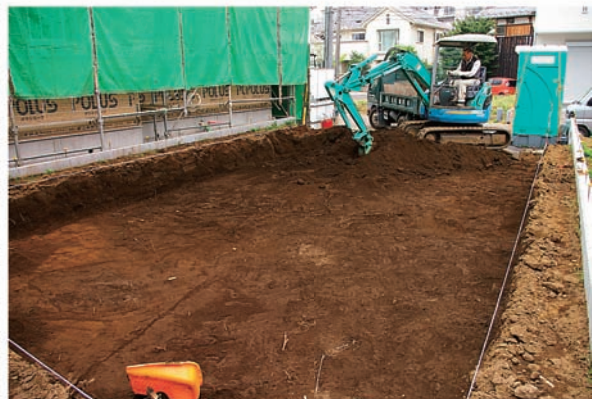
6. 第62⑩地点表土剥ぎ風景
