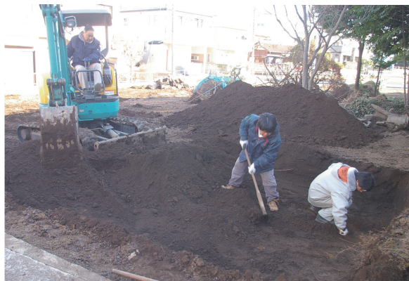
2. 表土剥ぎ風景
