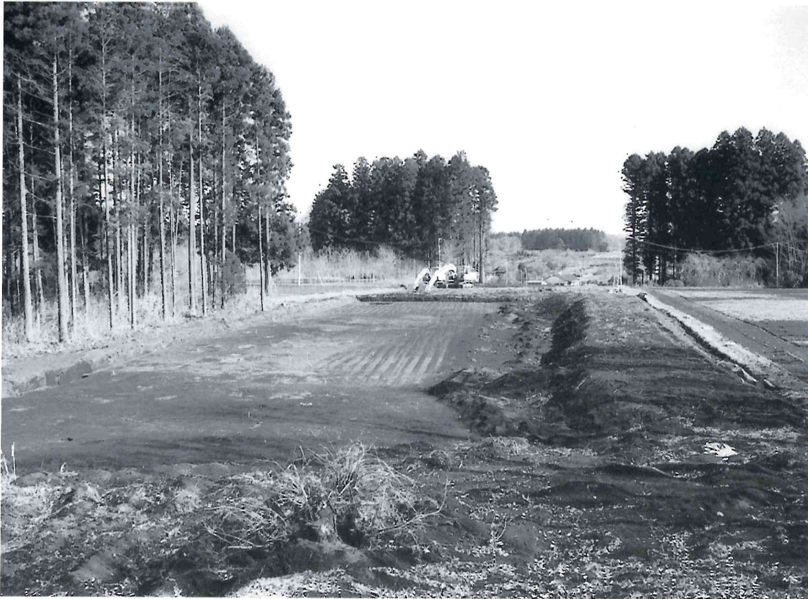
調査地区表土除去状況（西から）
