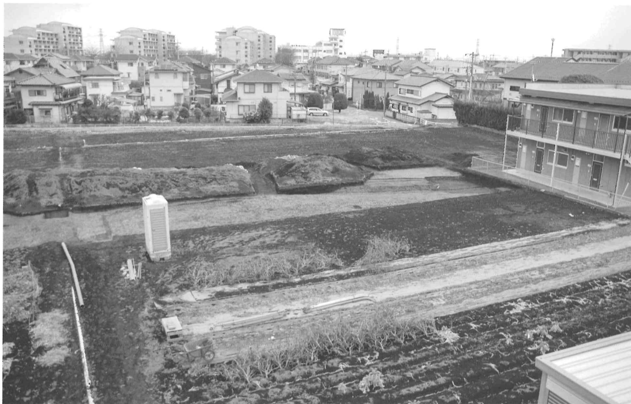
調査区全景南（西から）
