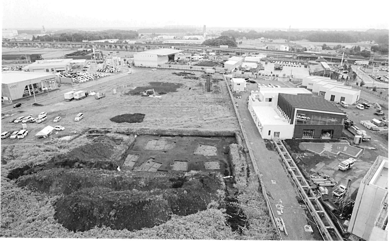
A. 調査区全景空中写真（手前G区、奥H区、西より）
