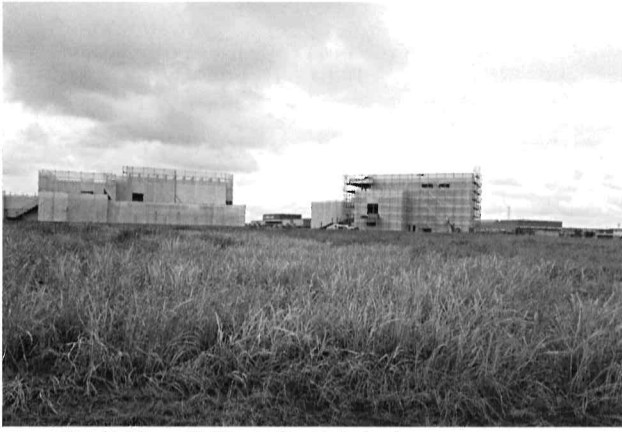
A. 調査前の状況（北東より）
