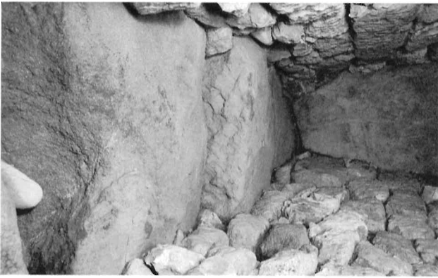
D. 同前天井石 (南下方より)
