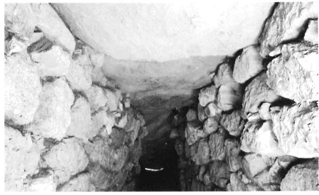
H. 同前天井石（北下方より）
