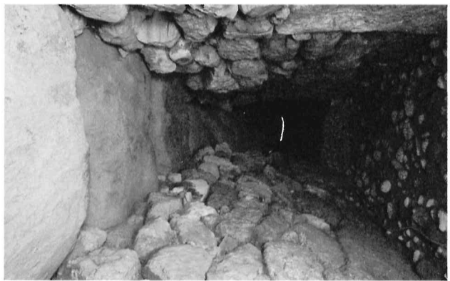
G. 同前南半部 (北下方より)
