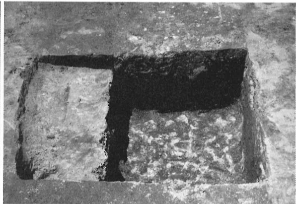
②29号・30号セクション (東より)
