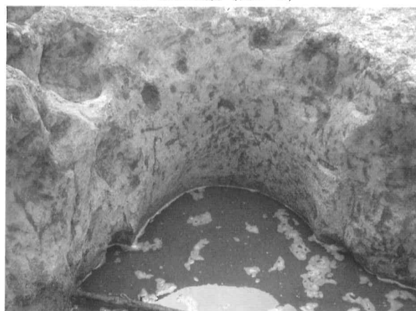
F. SE3全景 (南から)
