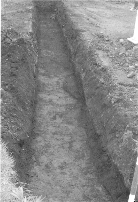
T 9 遺構確認状況 (北から)
