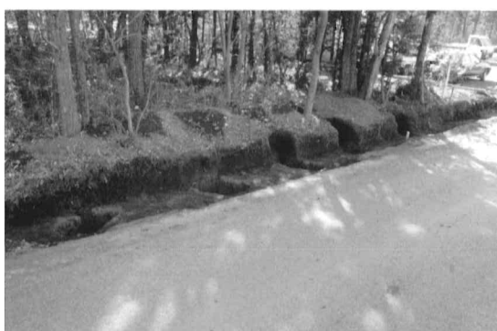
⑧SB60 完掘状況
