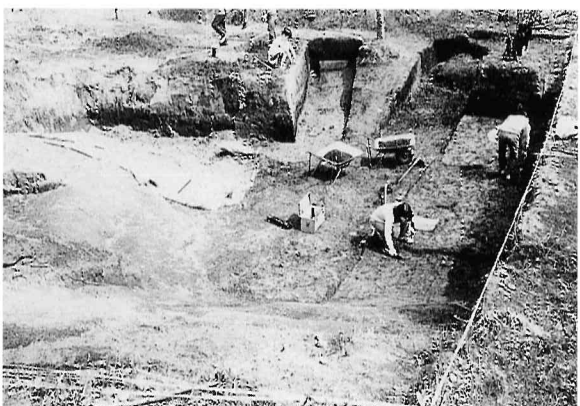
(8)T-6：東側くびれ部作業風景（1998年）
