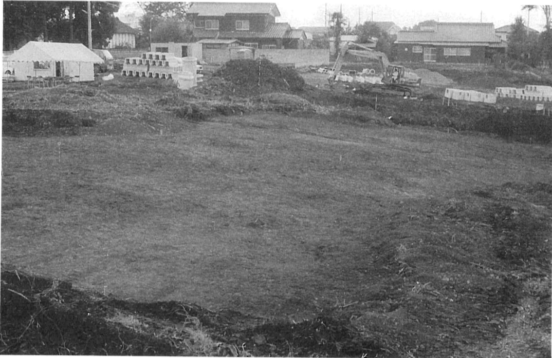
②調査区全景〔表土除去時〕（北西より）
