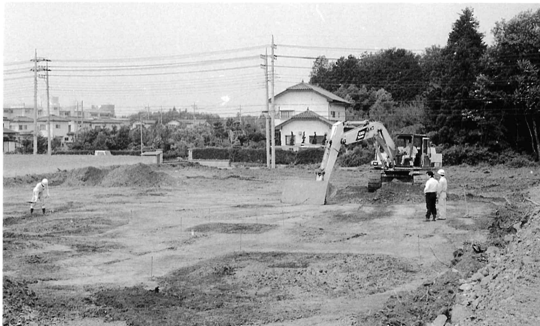
① 確認調査風景（東より）
