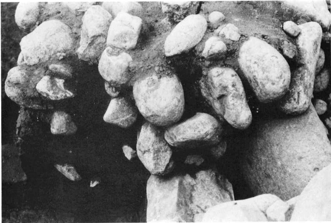
(2) 1号墳横穴式石室閉塞の断面（東方より）
