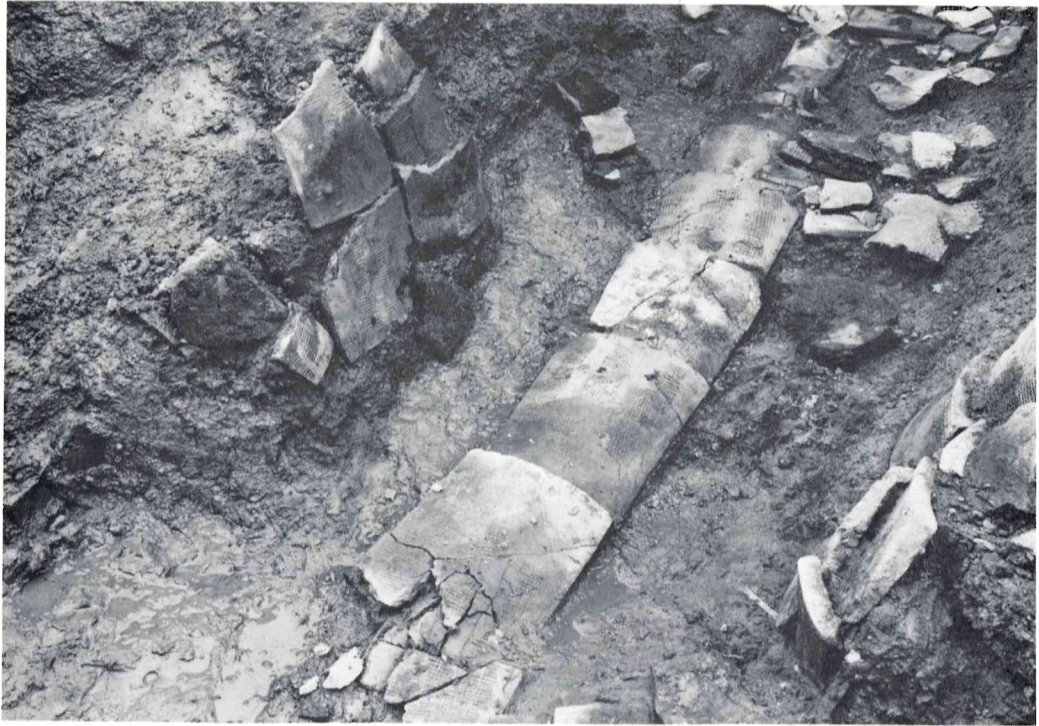
3号窯跡燃焼部
