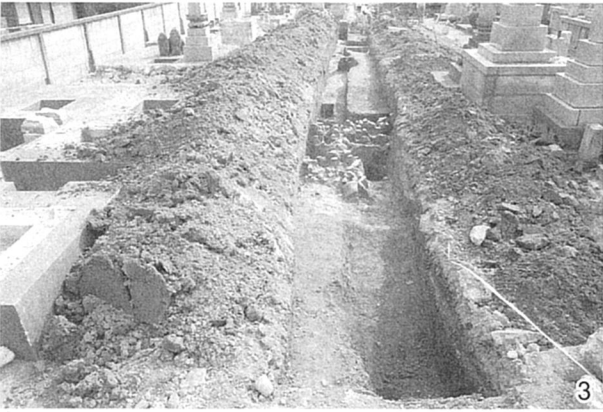
試掘2トレンチ（北から）
