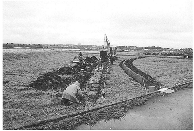
試掘調査風景（7トレンチ）
