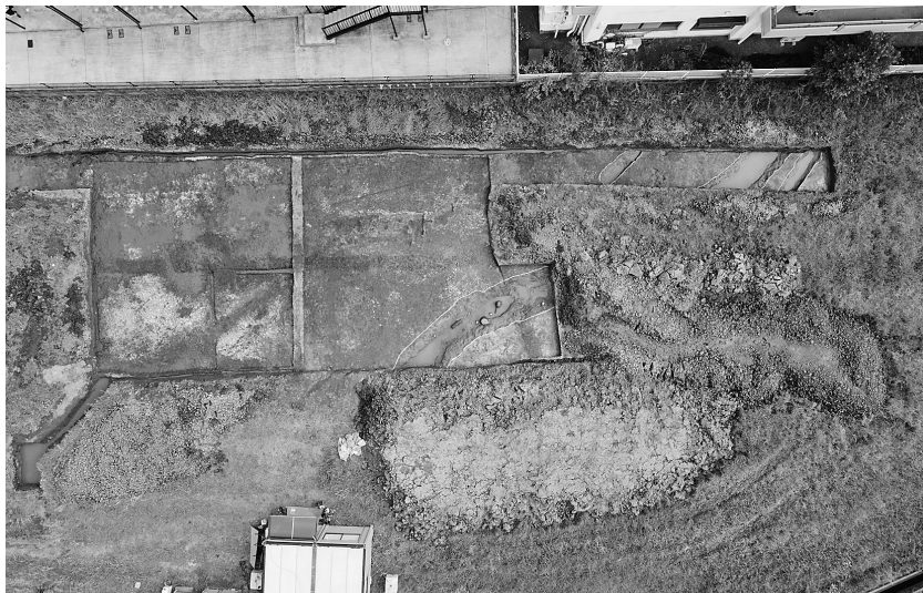
1区完掘全景（左側の黒く見えるところが旧河道の最後の堆積層）
