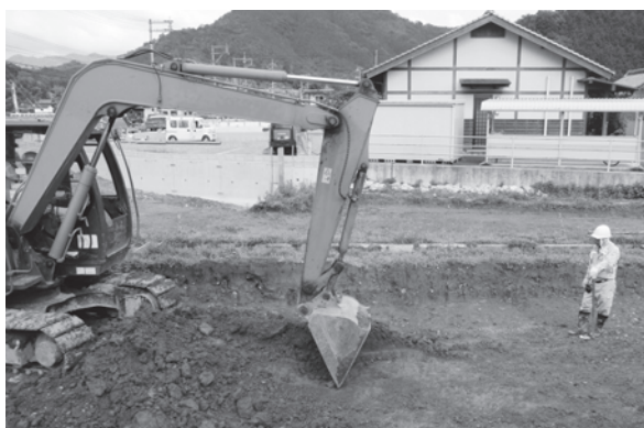
重機による表土除去
