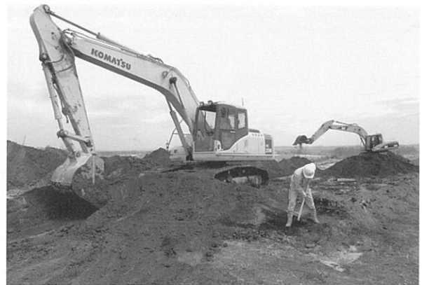
3. 包含層除去状況 (SW→)
