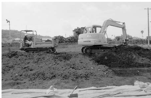
重機掘削風景
