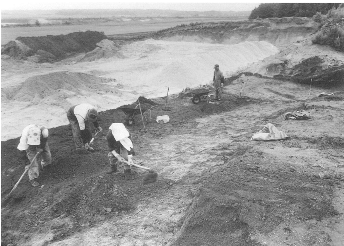
作業状況 (SW→)
