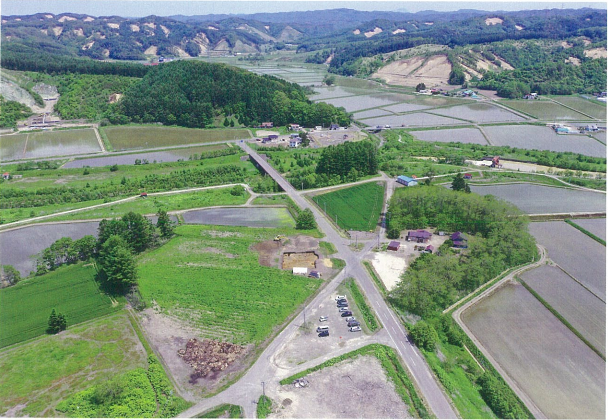
1. 調査地点近景（空撮）S →
