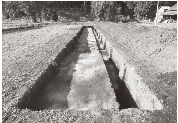
埋戻し前山砂散布状況 (31T)
