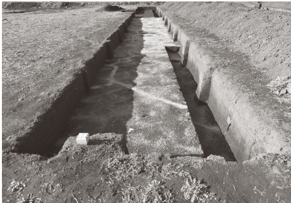
埋戻し前山砂散布状況 (30T)
