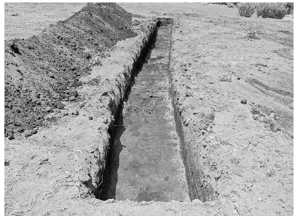
第72図 馬場先遺跡第2号トレンチ写真(東から)
