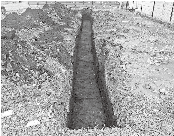
第65図 坪井上遺跡第1号トレンチ写真(南東から)
