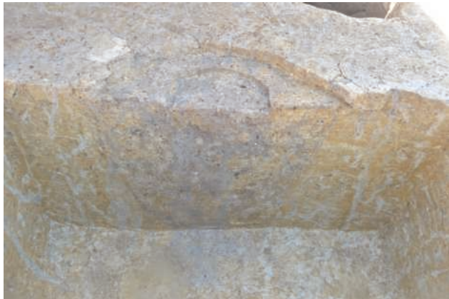
SP1-2 断面状況（北から）
