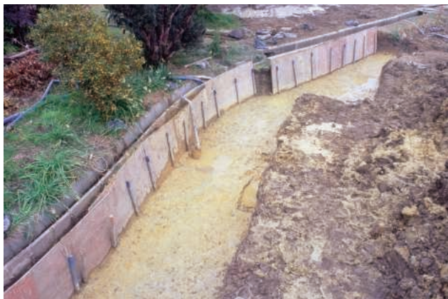
3区東半 全景（南西から）
