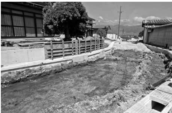
調査区西端 工事立会い状況
