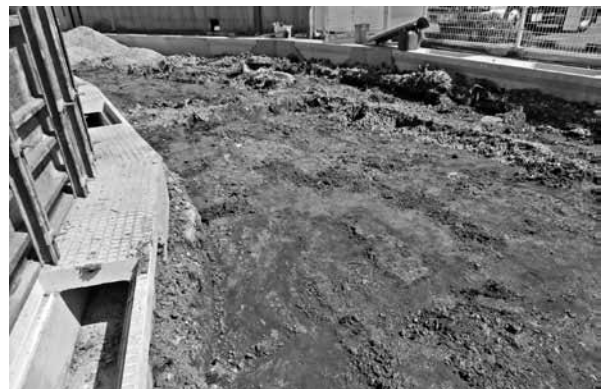
調査区西端 工事立会い状況
