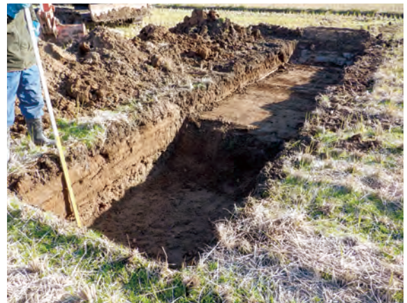
12号トレンチ土層状況 (北西→)
