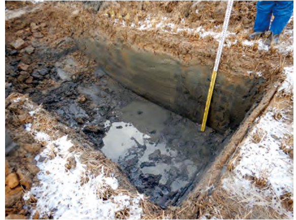
5号トレンチ調査状況 (南→)
