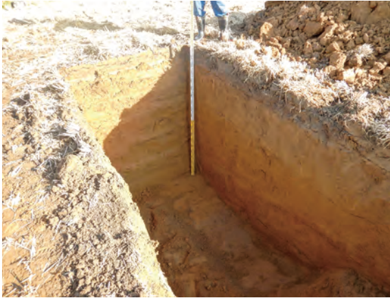
1号トレンチ調査状況(南西→)
