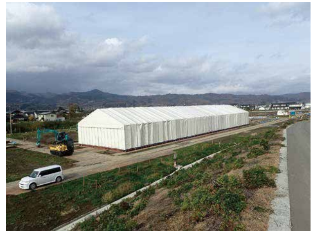
図8 大型テント設置
