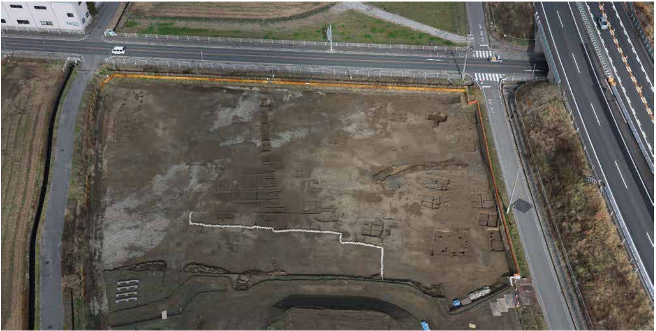
図43 調査区全景（南方上空から 右は長野自動車道）
