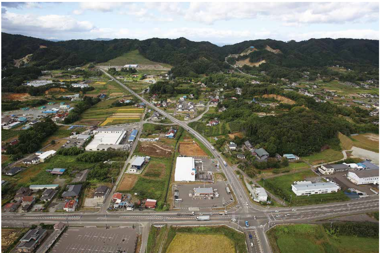
2. 北経塚遺跡G区調査区遠景（東から撮影）
