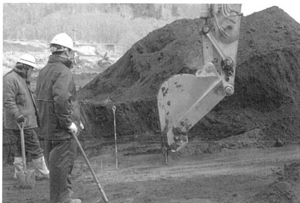
1. 平成19年度火山灰除去状況
