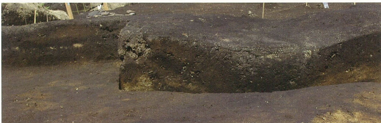
2. 封土断面(S→)[Ta-c主体の褐色土が封土 写真左側の封土下の斑状白色土はB-Tm]
