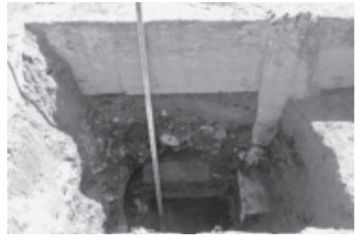
B. 工学部資源棟新営工事 TP 07（北より） 調査番号：2120
