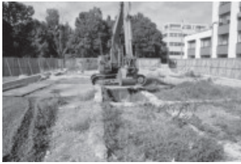
A. 工学部資源棟新営工事（東より） 調査番号：2120
