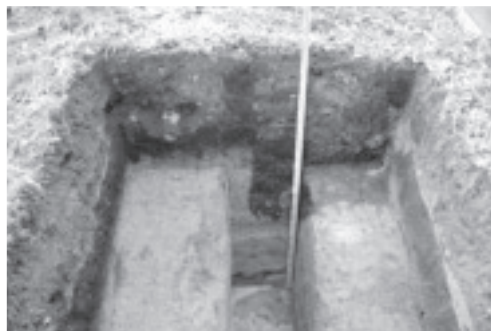
D. 大学病院院外薬局新営工事 TP 01（東より） 調査番号：2129
