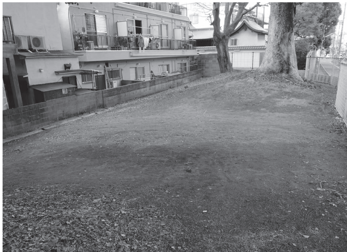
第2トレンチ調査終了状況（東より）
