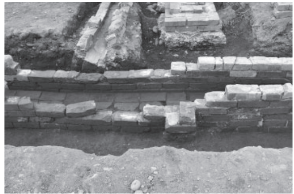
レンガ積 U 字形排水路（排水路 3）
