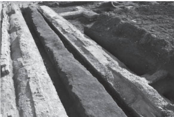
菊寮のコンクリート基礎（台形断面）
