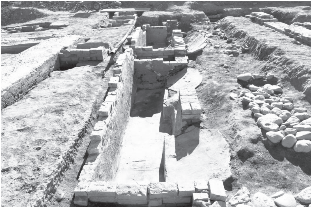
竹寮東端：便所 SB374 と排水路 4（SD58B 集水マス）全景（北から）
