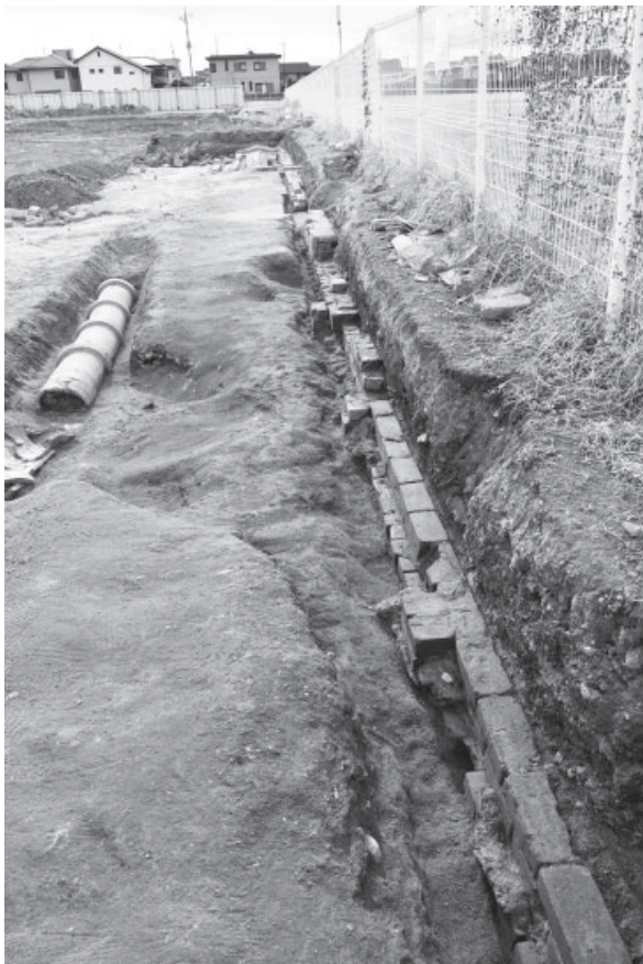
隔離室北西外側：壁基礎 SB283（北から）
