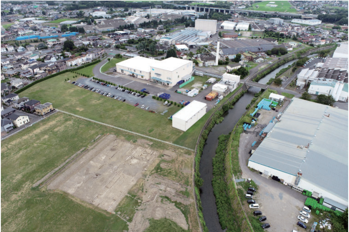
萩寮跡（中央手前左）上空からの旧鐘紡新町工場域鳥瞰（2020年8月27日）
