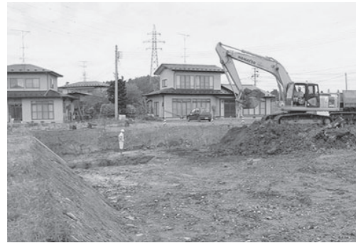
図3 表土除去作業
