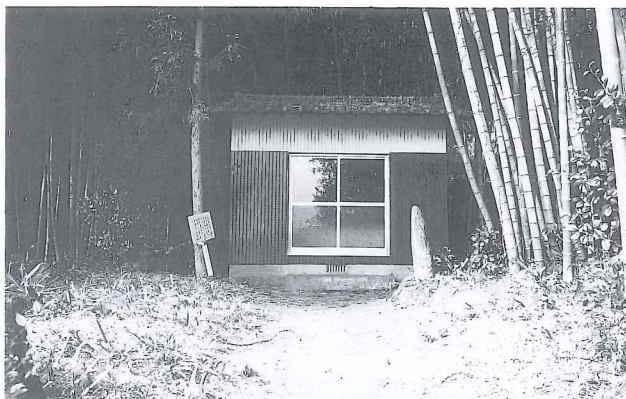
写真55 道脇寺観音堂
