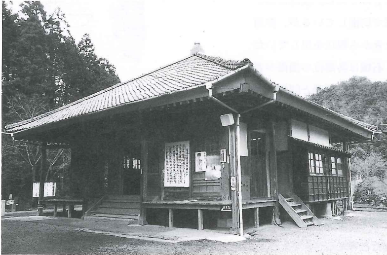
写真2 真木大堂近景 (南西から)
