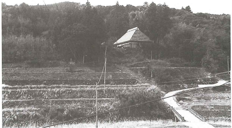
写真22 丸小野寺遠景 (北から)
