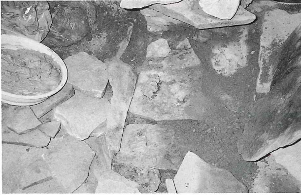
1. 基底部のくさび形石材の接着
