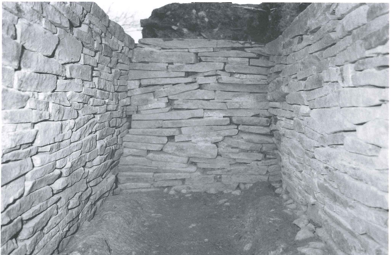
修復後の東短側壁
