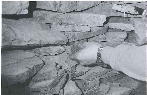
4. 同 側壁裏込めの接着
