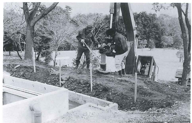
6. 墳丘盛土の締め固め
