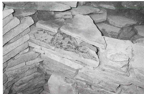
7. 割れた石材の接合（北長側壁西隅）
