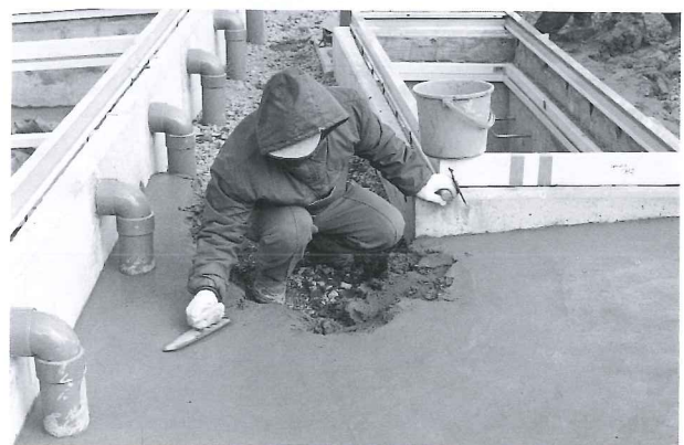
7. 墳頂部のソイルセメント
