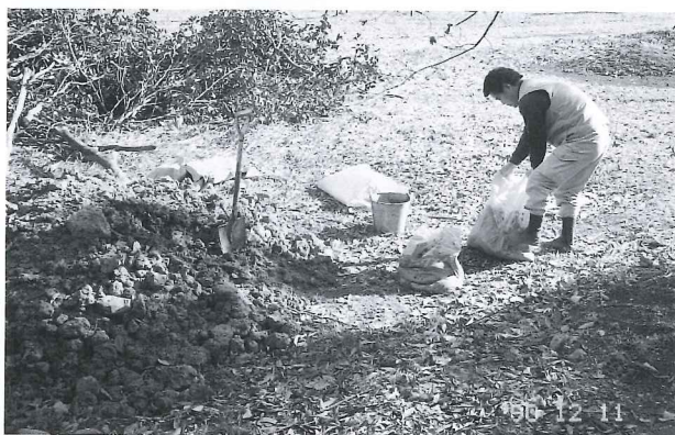
2. 竪穴式石室修復に用いる粘土の練込作業
