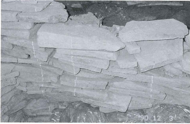
1. 北長側壁西部の修復準備
