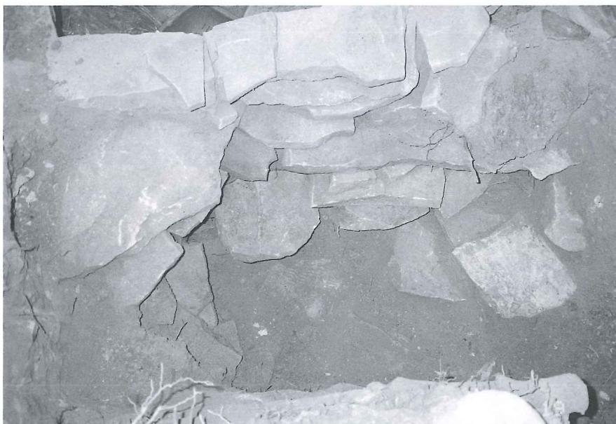
(根入れの深い大形石材を使用) 控積み除去後の東短側壁
