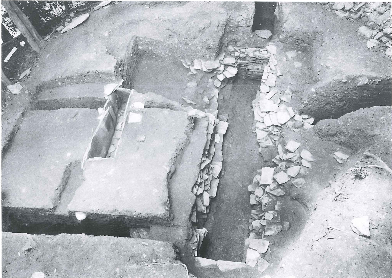
修復前の竪穴式石室と石棺（昭和63年）
