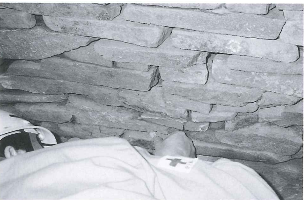
5. 同 側壁材間隙の清掃
