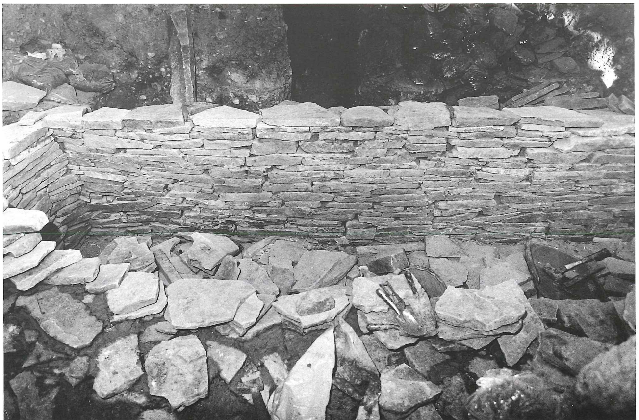
修復後の北長側壁西部（南より）
