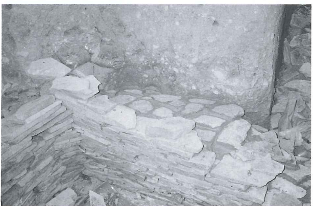
8. 同 修復完了（この後新規積層）
