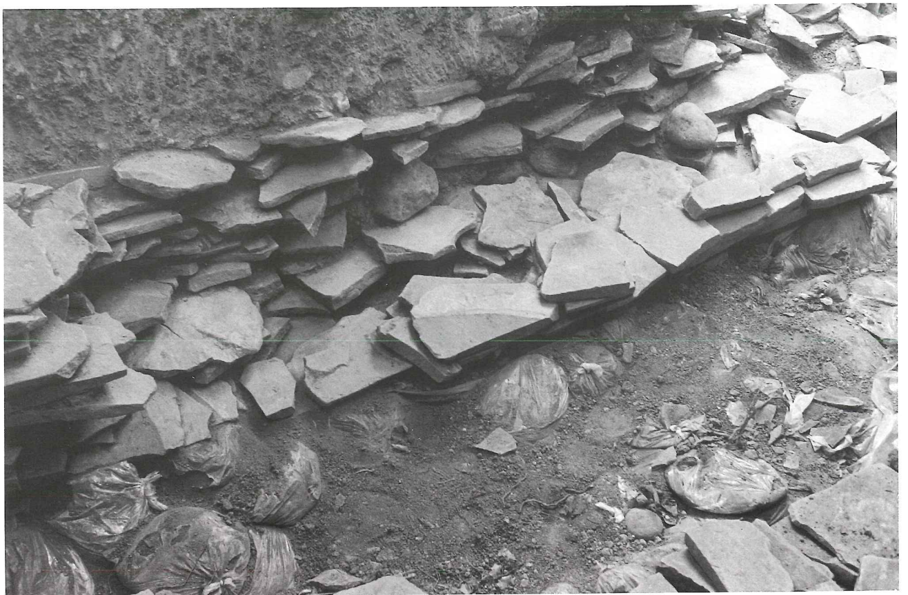
控積みの状況（南長側壁東部）
