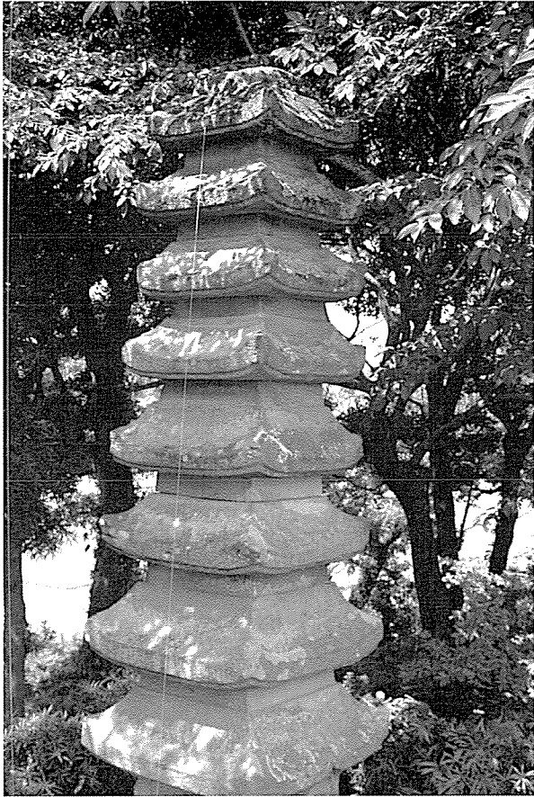
写真2 吉木九重塔上部
