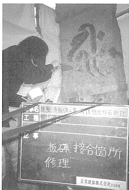
写真65 接合部の補修作業
