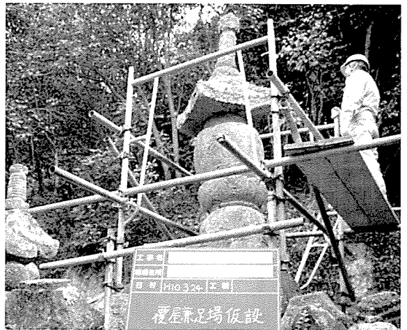
写真60 足場の仮設作業
