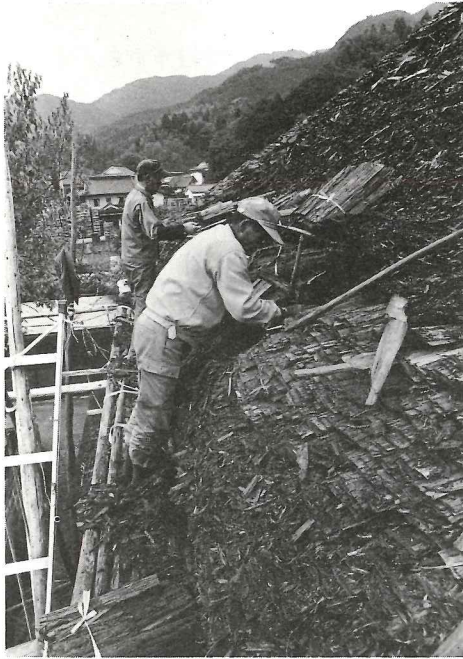
写真57 杉皮葺きの補修（日田市）
