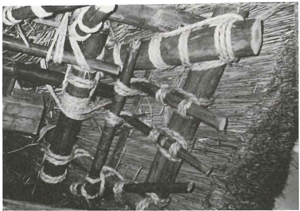
写真62 軒隅の小屋組み (日田市)
