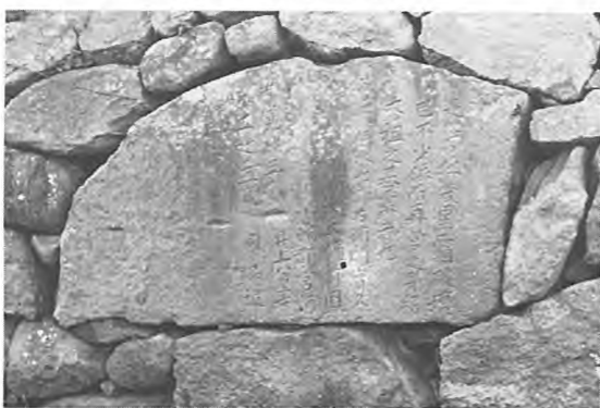
写真 46 富久浦久保屋敷跡石垣
