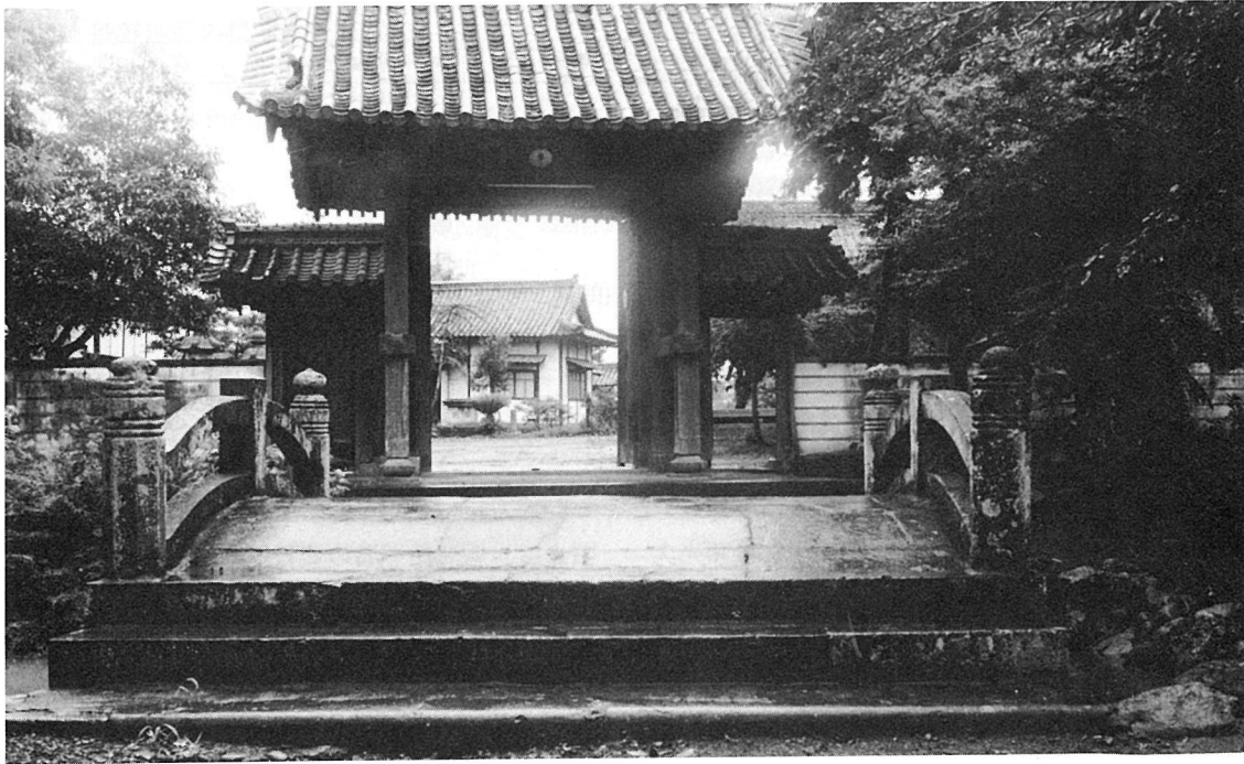
写真2 若宮八幡社石橋
