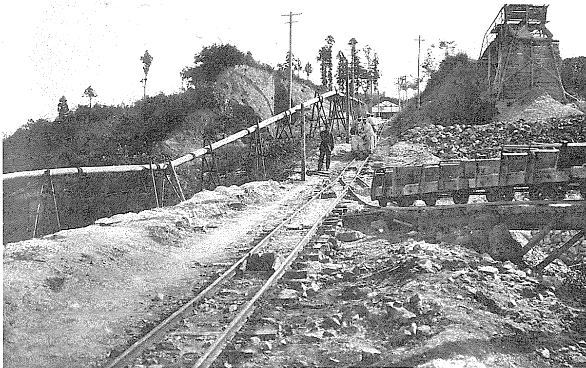
写真 168 馬上金山第 1 坑から巻揚機室をのぞむ
