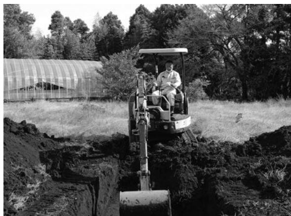
重機稼働状況 (西から)
