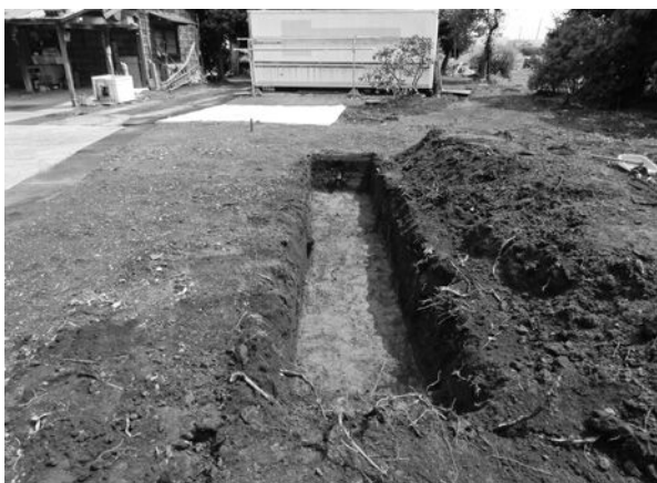
4号トレンチ (南西から)
