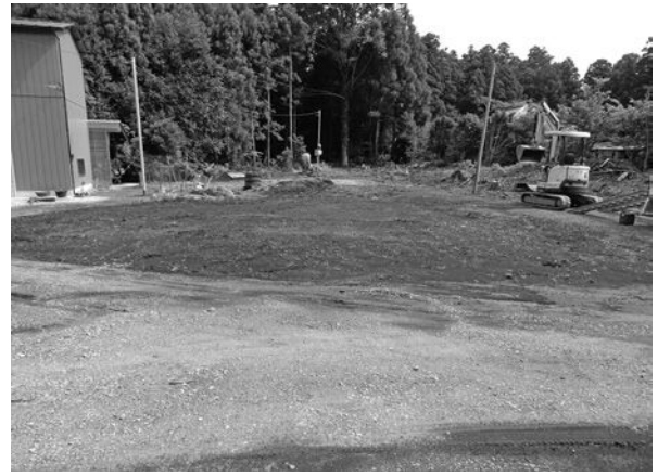
調査前風景 (南西から)
