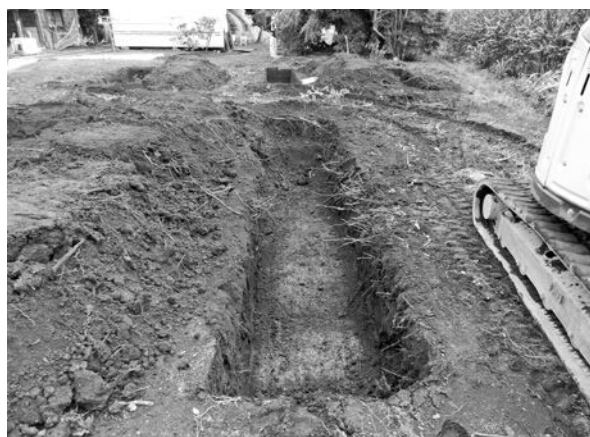
2号トレンチ (南西から)
