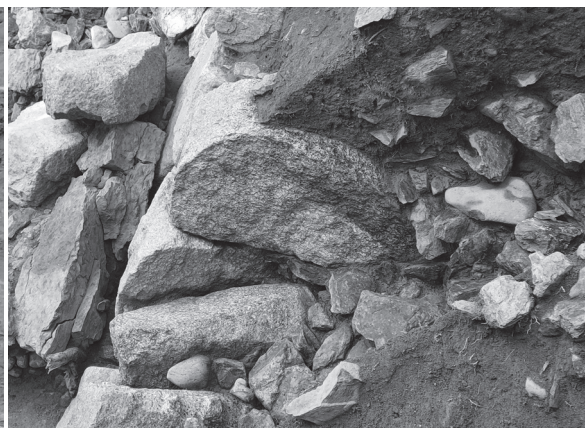
2 4区断割2積石部分断面(東から)
