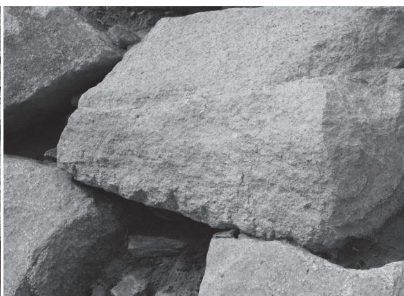
4 4区石材No.7ハツリ痕跡（南東から）
